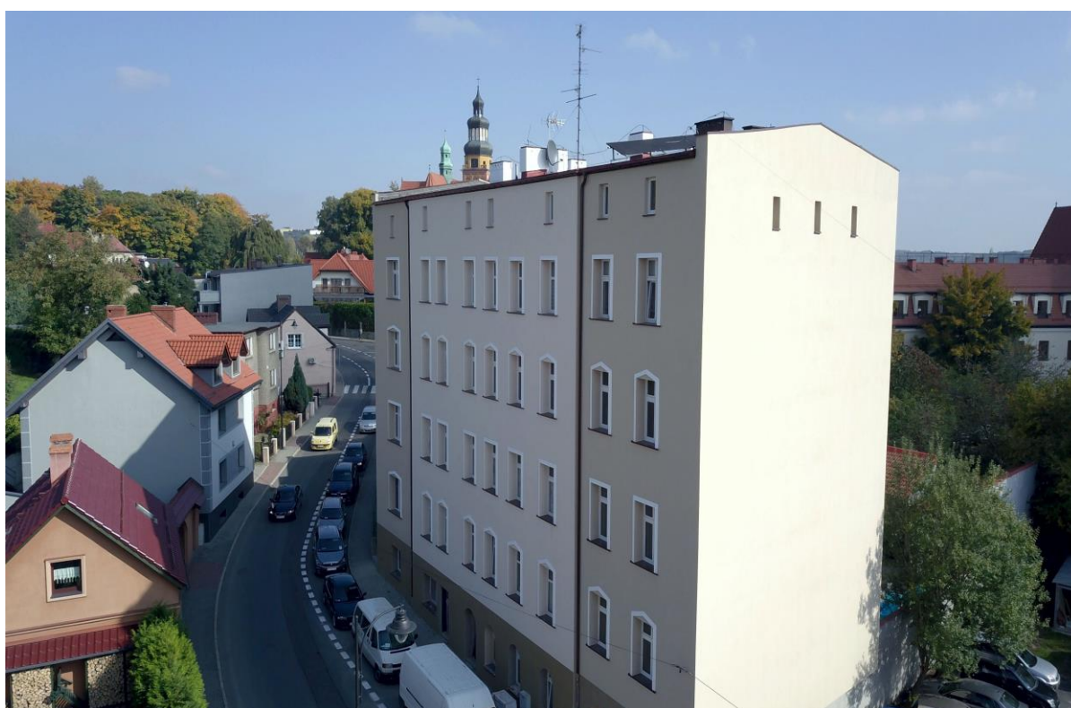
Termomodernizacja budynku przy ul. Wałowej 22 w Wodzisławiu Śląskim
