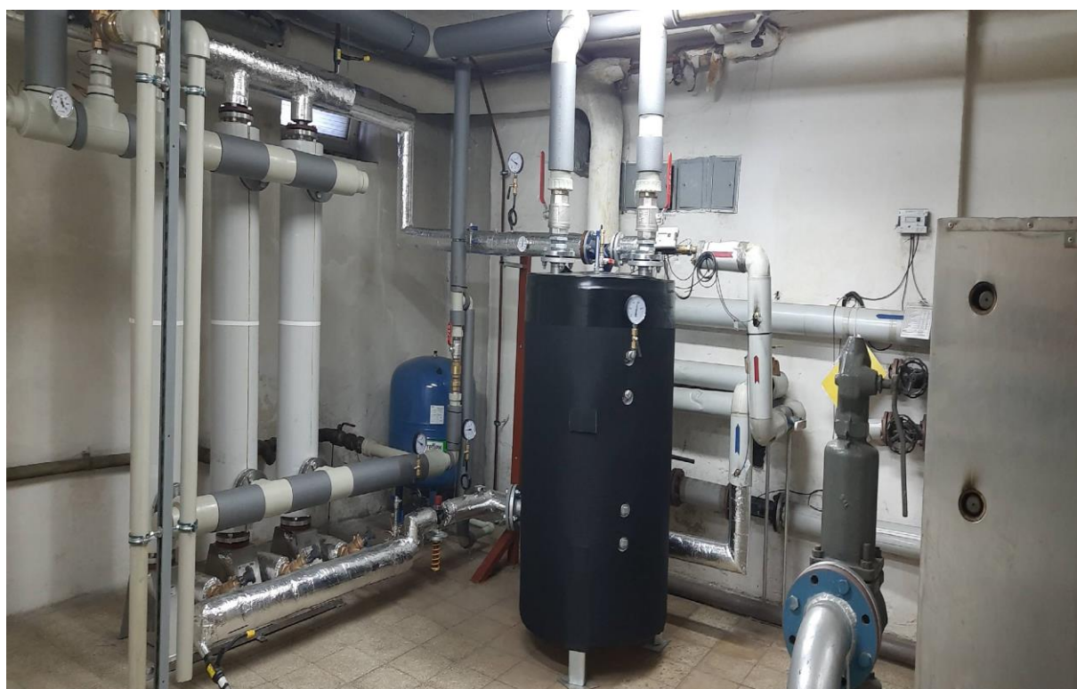
Modernizacja układu C.W.U. zbiorczej stacji dla budynków przy ul. Ofiar Terroru 93-97 w Rydułtowach
