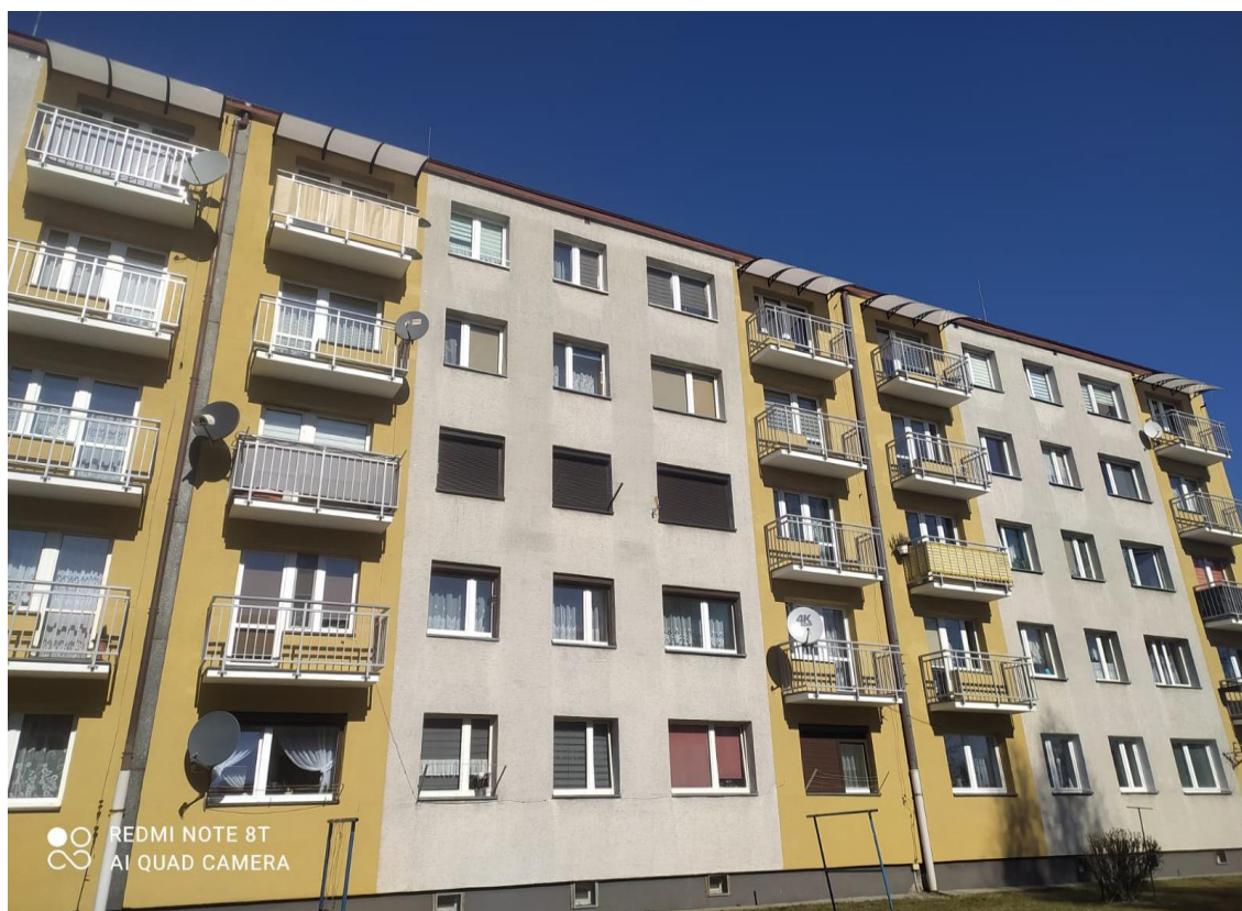
Remont balkonów w budynku przy ul. Józefa Tytki w Pszowie
