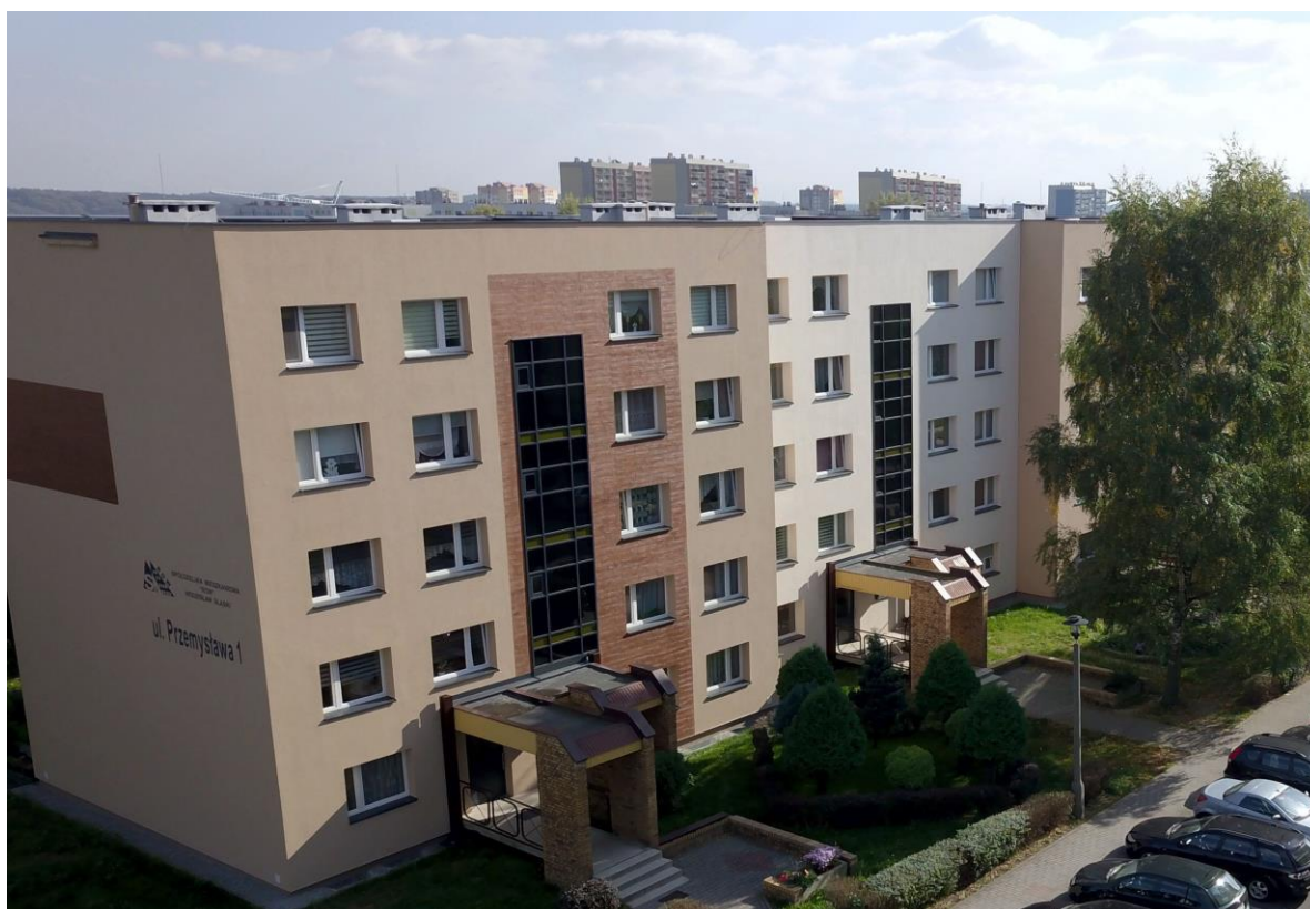
Termomodernizacja budynku przy ul. Przemysława 1 w Wodzisławiu Śląskim
