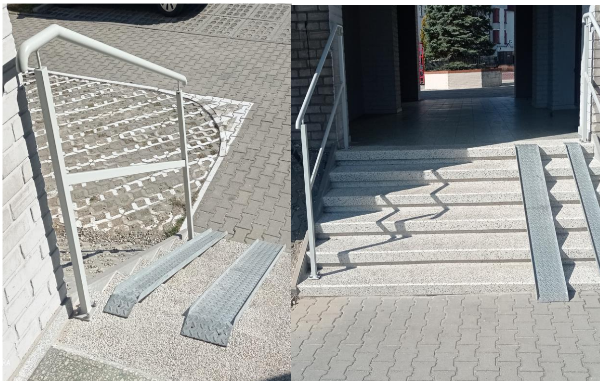
Remont schodów i wykonanie balustrad w budynku os. Dąbrówki 12 w Wodzisławiu Śląskim
