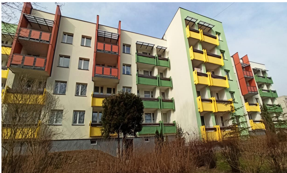
Termomodernizacja budynku przy ul. Przemysława 11 w Wodzisławiu Śląskim Osiedle Dąbrówki
