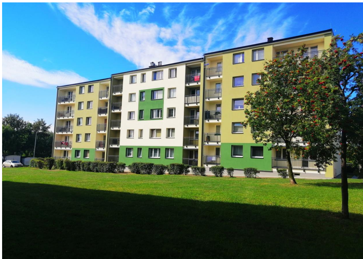
Termomodernizacja budynku przy ul. Stanisława Ligonia 12 w Rydułtowach
