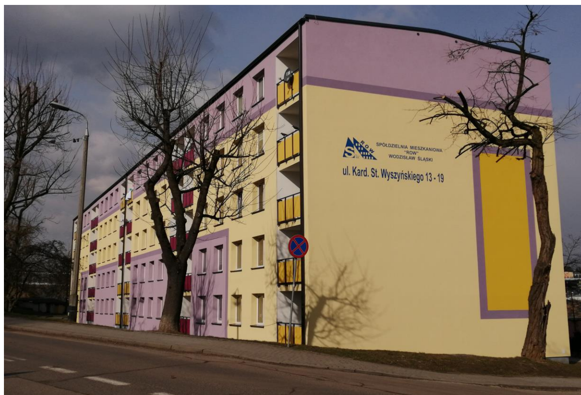
Termomodernizacja budynku przy ul. Kard. St. Wyszyńskiego 13-19 w Wodzisławiu Śląskim
