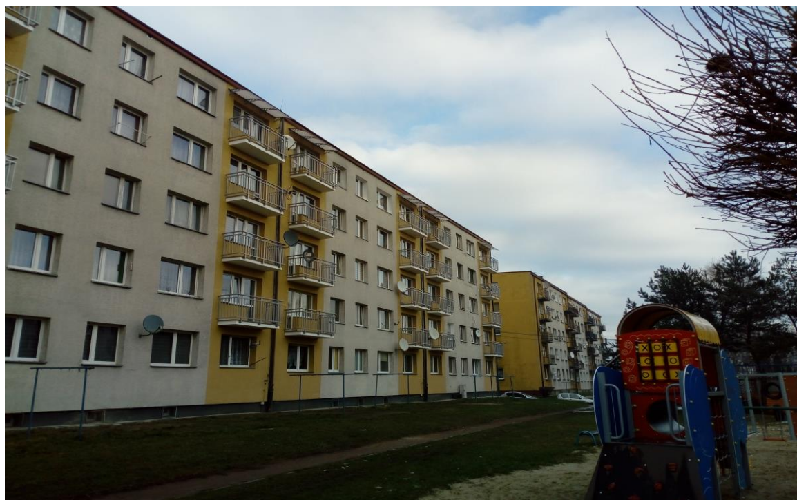
Remont balkonów w budynku przy ul. Józefa Tytki 1 w Pszowie Osiedle Centrum
