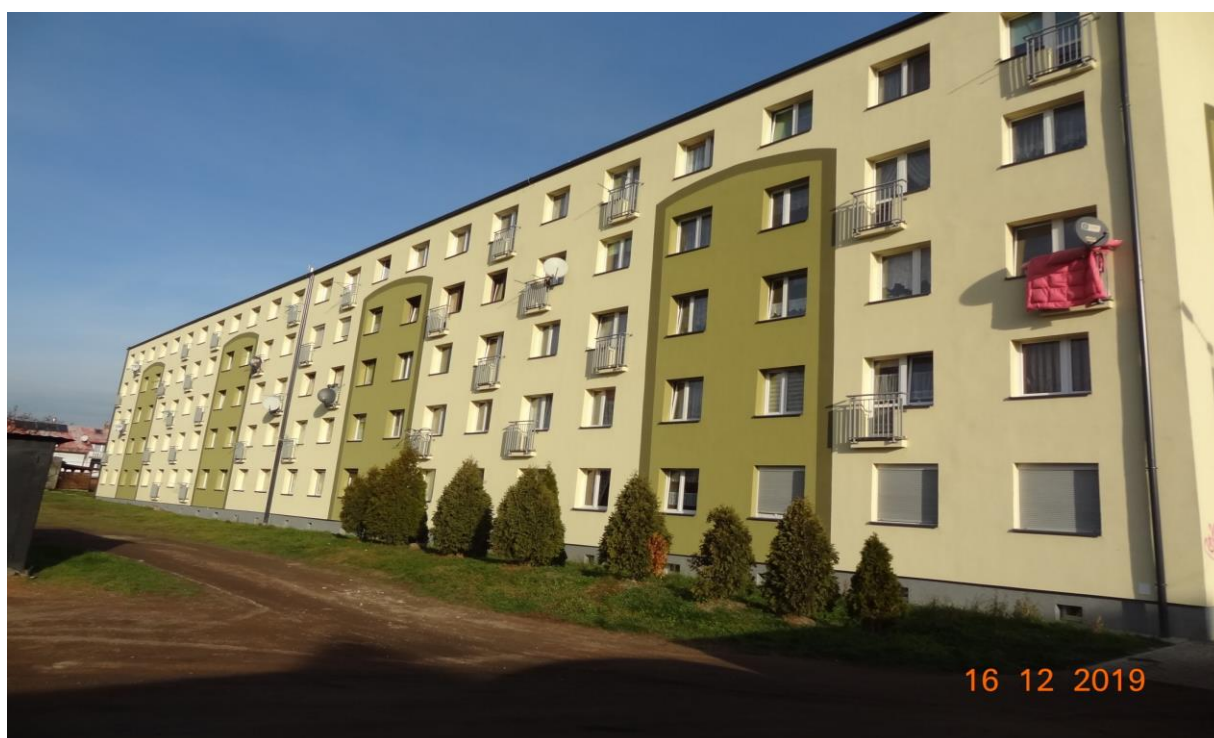
Termomodernizacja budynków przy ul. Krzyżkowickiej 20, 22, 24
