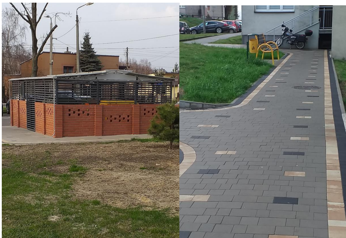
Remont chodnika i wykonanie śmietnika na placu gospodarczym przy ul. Jagienki w Pszowie
