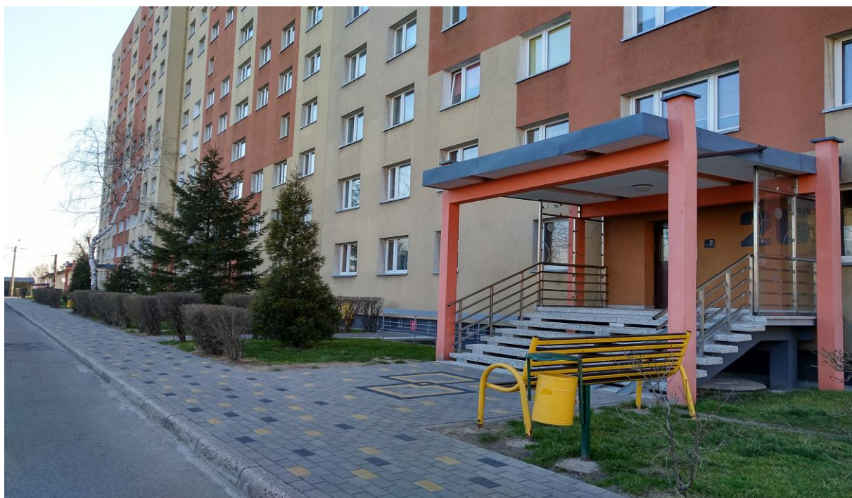
Remont chodnika przy ul. Sienkiewicza w Radlinie
