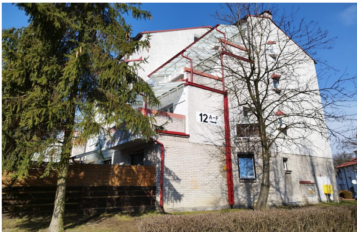
Remont balkonów w budynku os. Dąbrówki 12 w Wodzisławiu Śląskim
