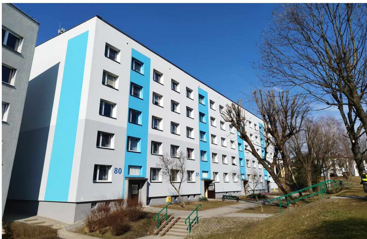
Termomodernizacja budynku os. XXX - lecia 80 - 83 w Wodzisławiu Śląskim
