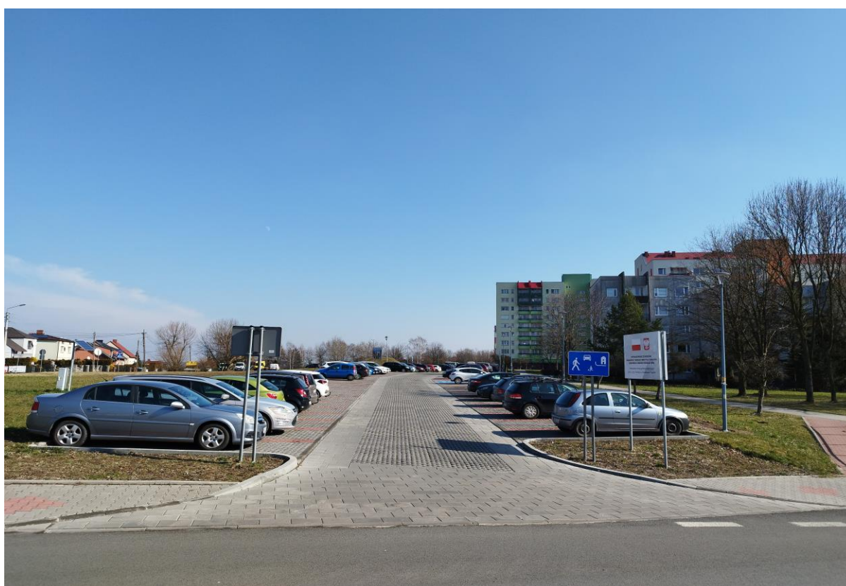
Wykonanie parkingu przy ul. Przemysława 2 w Wodzisławiu Śląskim
