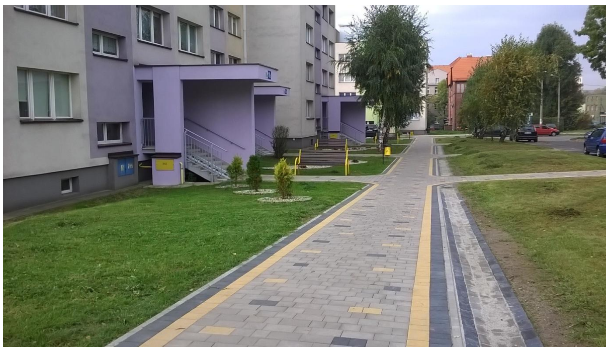
Remont wejść i chodników przy ul. Traugutta 18 w Pszowie
