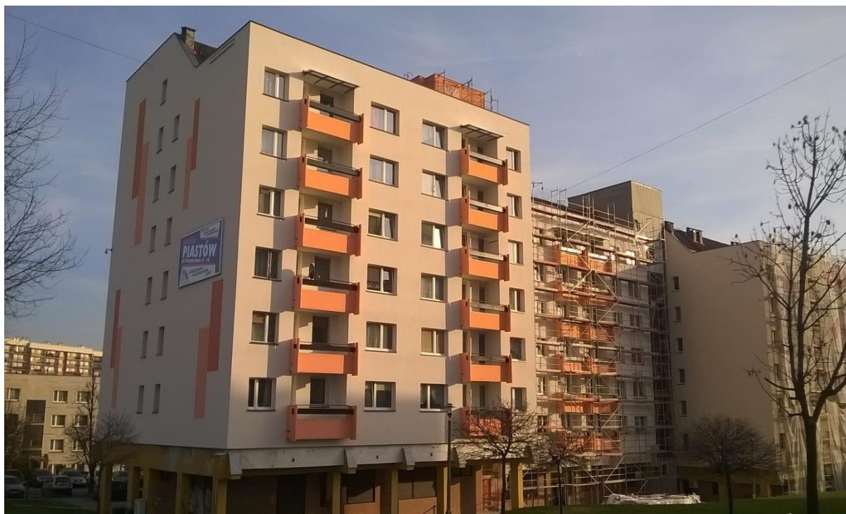
Termomodernizacja budynku przy ul. Przemysława 9 w Wodzisławiu Śląskim
