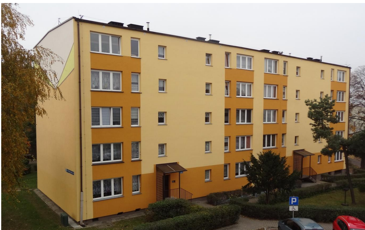
Odnowienie elewacji budynku przy ul. Plebiscytowej 34 w Rydułtowach
