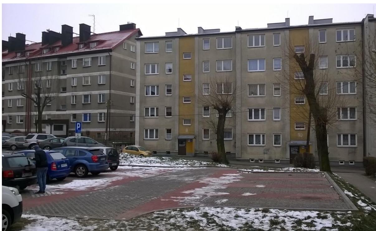
Wykonanie miejsc postojowych przy ul. Makuszyńskiego 8-12 w Radlinie
