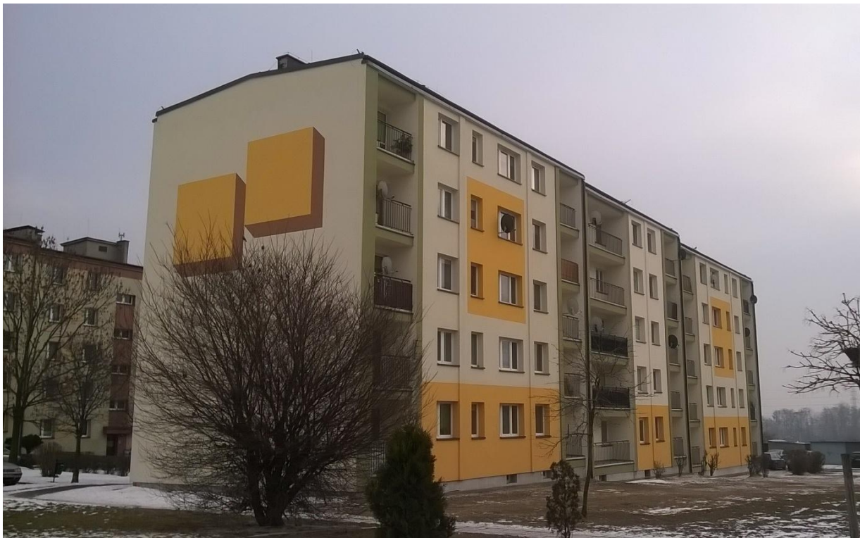
Docieplenie elewacji szczytowych i balkonowej ul. Ligonia 14 w Rydułtowach
